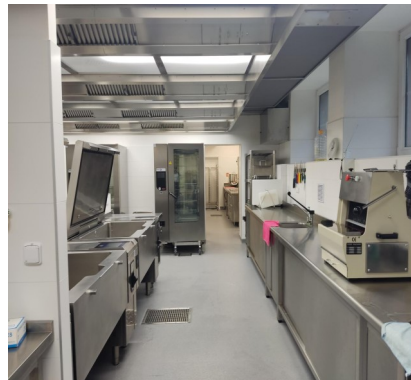
Pohled na chodbu kuchyně
